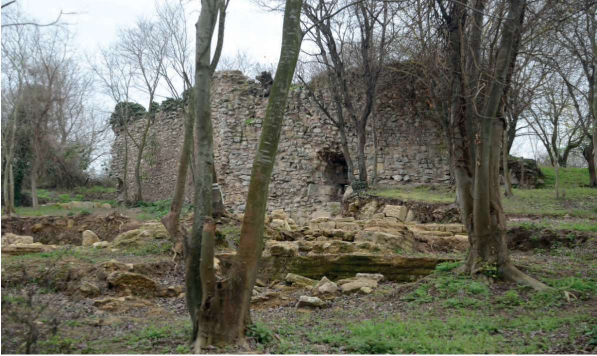
Res. 1: 8/11-14I açmasının kenarındaki sur duvarı.
