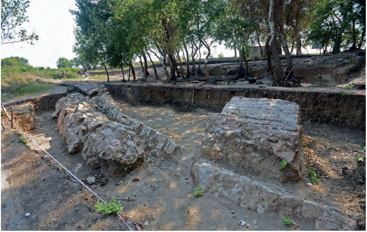
Res. 5: Sarnıcın doğu duvarında gerçekleşmiş kayma.
