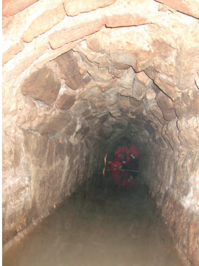
Res. 12: Sarnıca, yer altı kaynak suyunu sağlayan kanallardan birinde yapılan araştırma.
