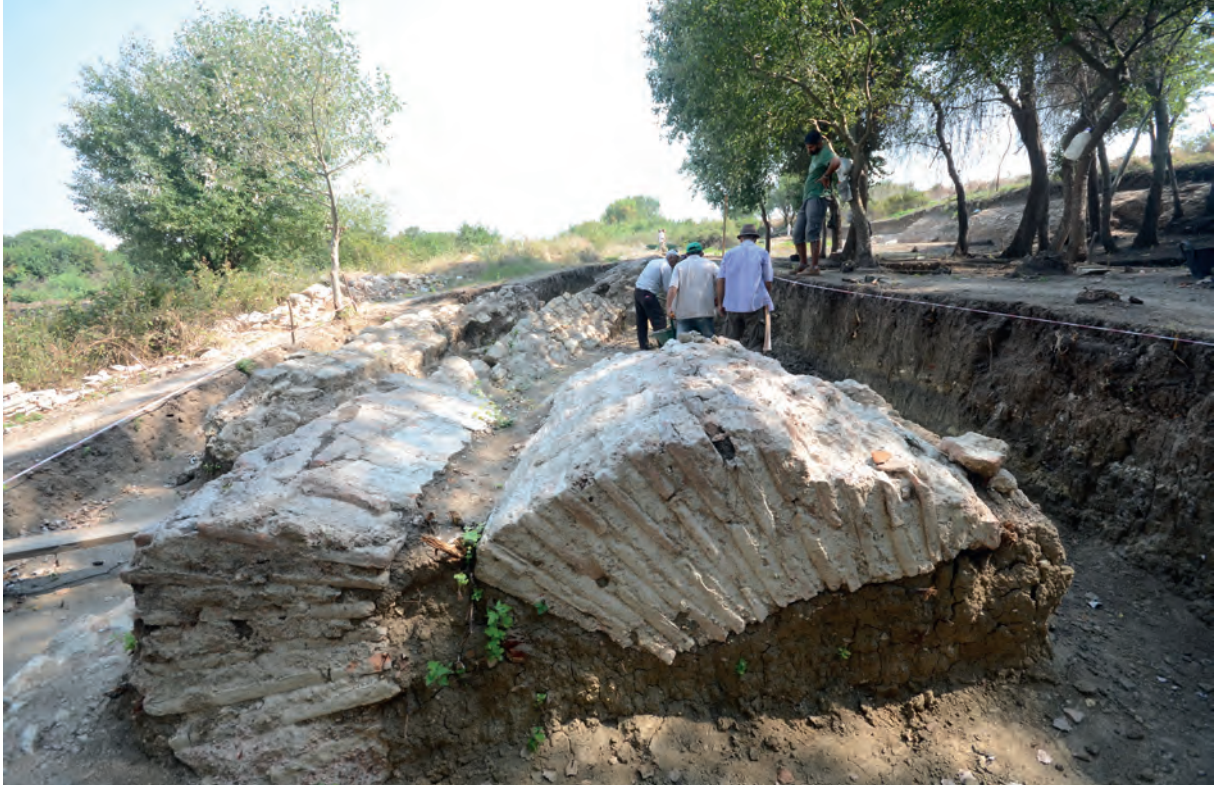
Res. 6 Sarnıcın doğu duvarında gerçekleşmiş kayma.
