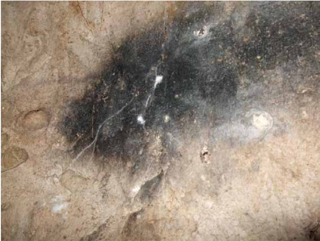
Res. 18: 'Sarkan kökler galerisi'nin sonundaki duvardaki is lekesi (H. Eğilmez).
