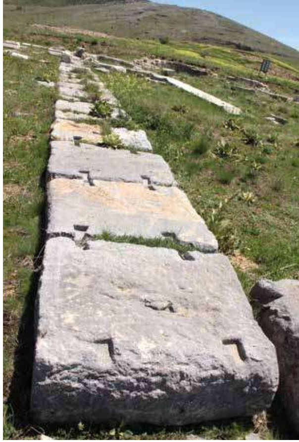
Şek. 28: Pisidia Antiokheia'daki Kuzey Bazilika'nın kırlangıçkuyruğu krampları tekniği ile birleştirilmiş taş bloklardan yapılmış stylobat (Fotoğraf: B. Stanislawski)
