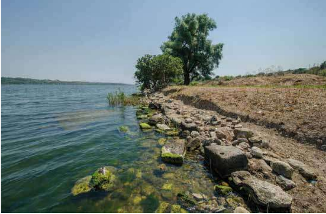
Şek. 3: Bathonea kıyısındaki rıhtım duvarı veya tarım alanını korumak için yapılmış set yapısı kalıntıları (Fotoğraf: H. Öniz) Fig. 3: Remains of a quay wall or embankment built to protect farmland on the coast of Bathonea (Photograph: H. Öniz)
