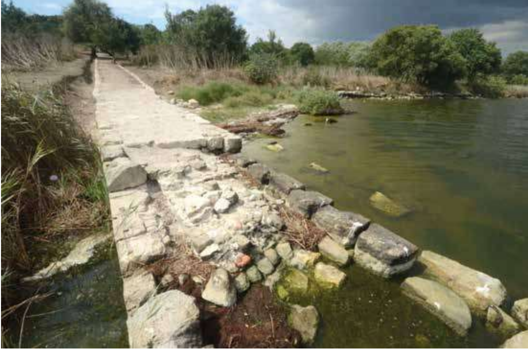
Şek. 5: Küçük Liman Bölgesindeki sandık formu iskele yapısı (Fotoğraf: H. Öniz) Fig. 5: The crate-shaped pier structure in the Small Harbor Area (Photograph: H. Öniz)
