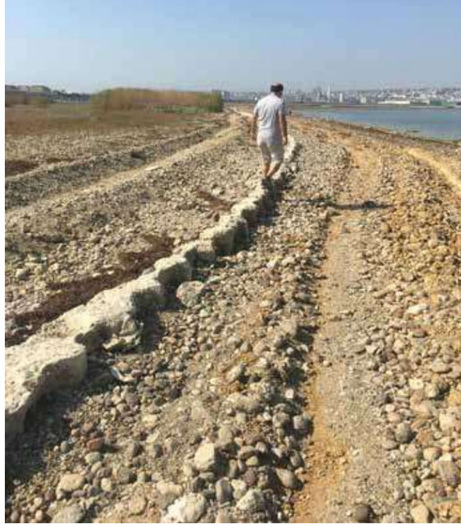
Şek. 9: MS 6. yüzyıla ait Rezervuar yapısının karada kalan bölümlerinden (Fotoğraf: H. Aydıngün) Fig. 9: One of the remaining parts of the Reservoir structure of the 6 th c.AD (Photograph: H. Aydıngün)
