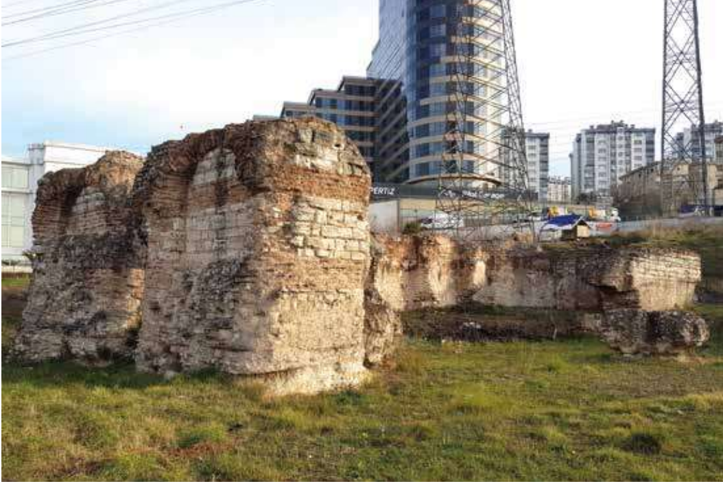
Şek. 7: Haramidere Sarnıcı (Fotoğraf: K. Altuğ) Fig. 7: Haramidere Cistern (Photograph: K. Altuğ)
