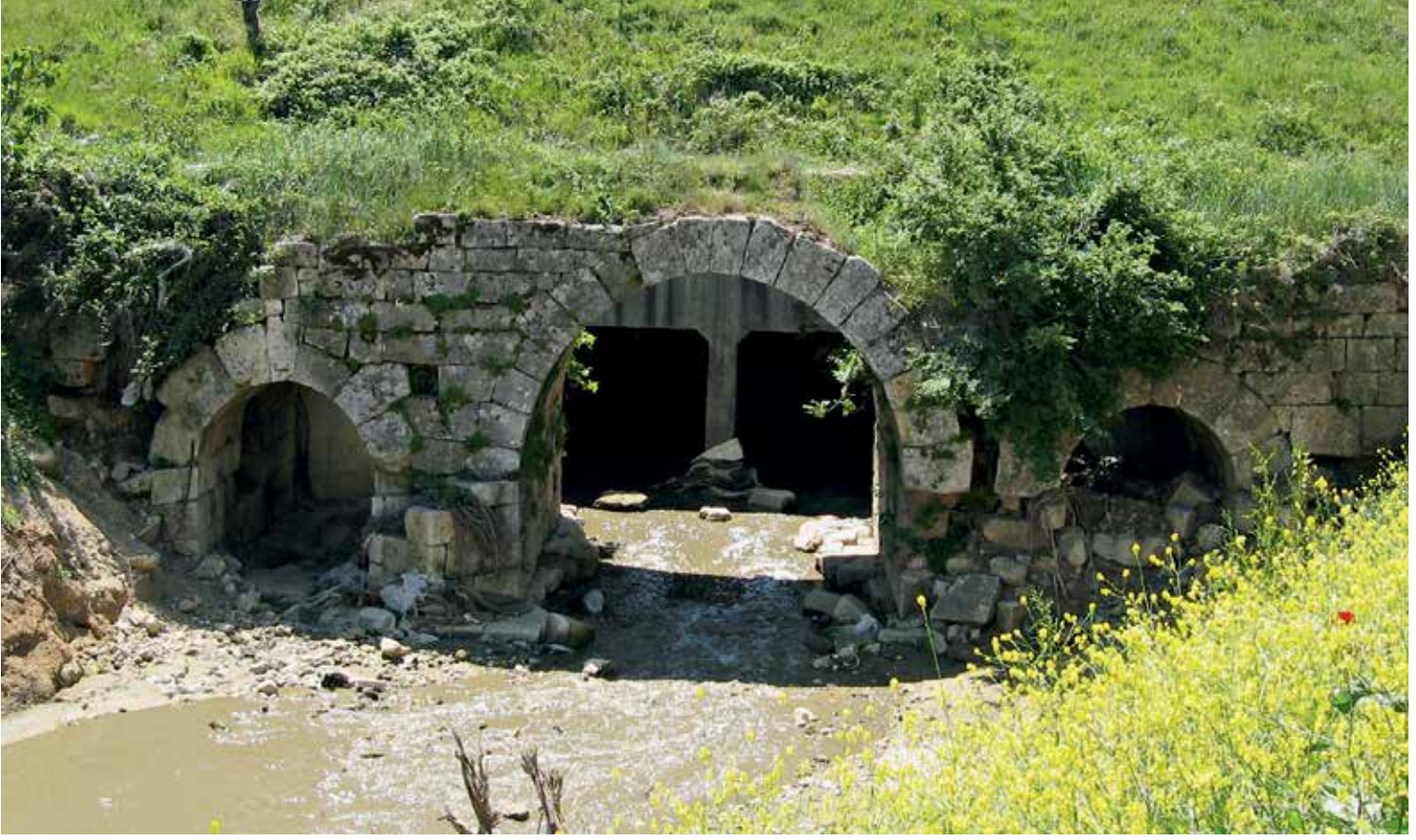
4- Başakşehir ilçesinde TEM Otoyolu kenarında yer alan Roma köprüsü
